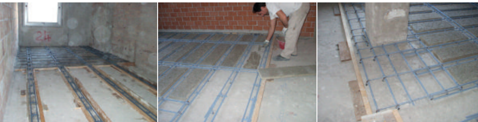
A sinistra, alcune immagini degli interventi per il rinforzo strutturale del solaio con interposto isolante.
